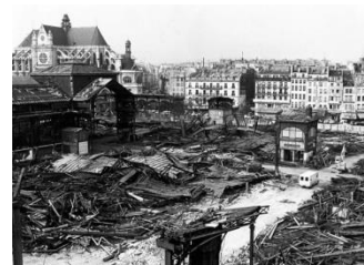
Fig. 01.22 – Destruição dos Halles de Paris
