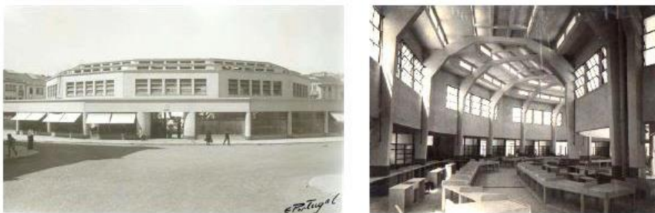
Fig. 00.2 e 00.3 - Fotografias do mercado de Arroios em 1939, Arquitecto Luís Benavente
